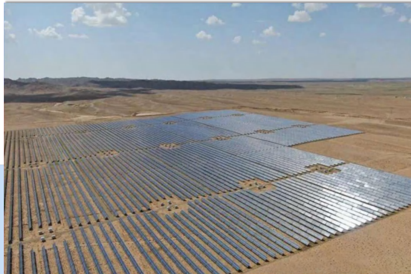
甘肃金昌100MW清河滩电站
